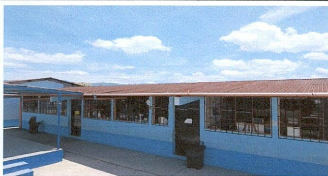
Foto 1: Sustitución de lámina, por lámina troquelada calibre 26 de modulo 3
