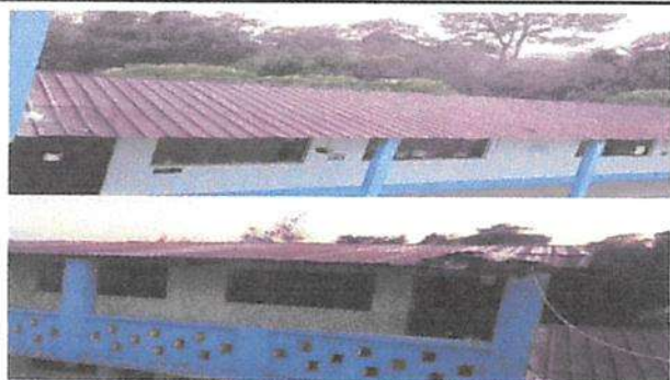
Foto 1: Cambio de cubierta de lámina troquelada calibre 24 módulos 1 y 2
