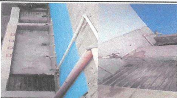
Foto 5: Sustitución de tubería de PVC de 1/2, de agua potable y chorros
