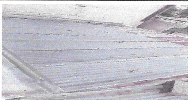
Foto 3: Cambio de cubierta de lámina troquelada calibre 24 de un aula con estructura metálica
