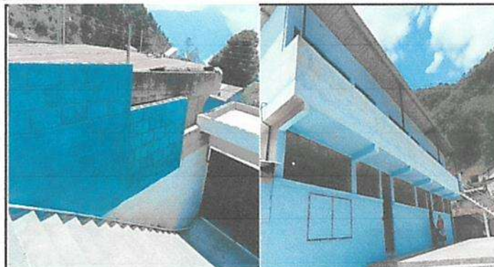
Mantenimiento de pintura interior y exterior.
