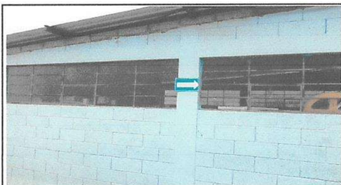
Sustitución de ventanas por ventanas de PVC
