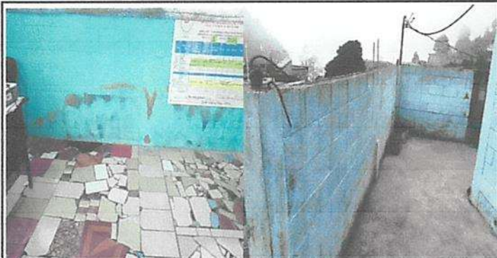
Mantenimiento de pintura interior y exterior.
