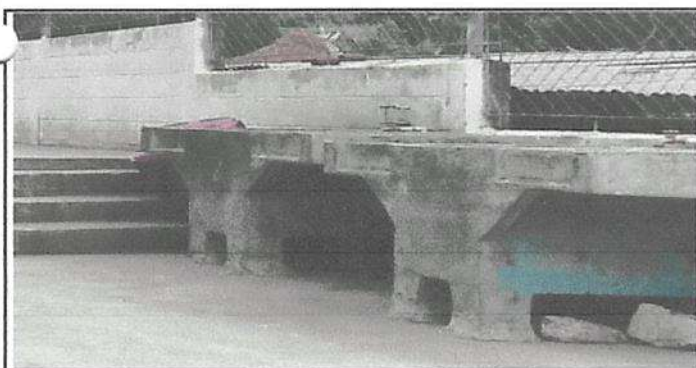
Sustitución de pilas
