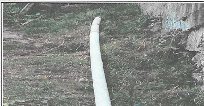
Mantenimiento red de drenaje.
