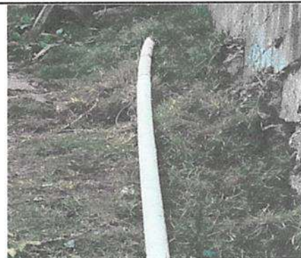
Mantenimiento de red de agua potable
