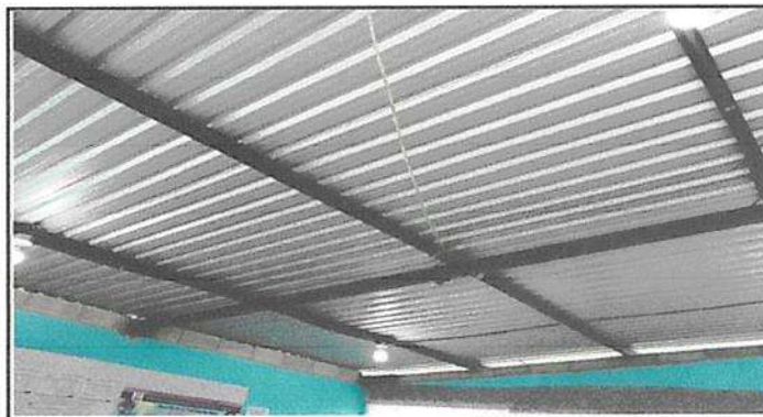
Sustitución de cielo falso
