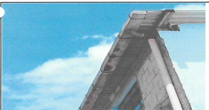
Sustitución de canales
