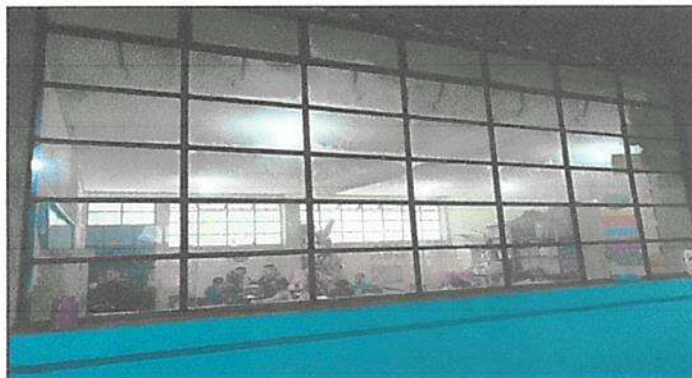
Mantenimiento de ventanas
