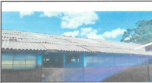
Sustitución de lámina existente por lámina troquelada calibre 26 de 1 metro de ancho útil por 98.20 mts de largo en Módulo 1
