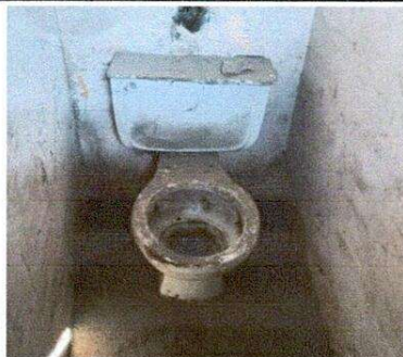
Sustitución de accesorios en módulo sanitarios 2; contrallave, manguera de abasto, sistema de flotador, asiento de plástico y tapadera de madera para tanque.
