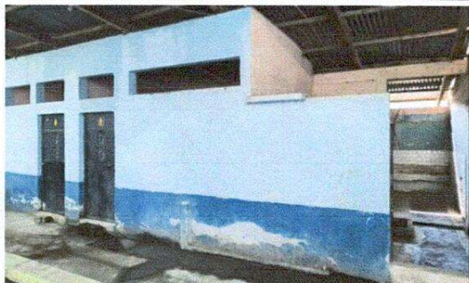
Aplicación de pintura látex en módulo de sanitarios 2.
