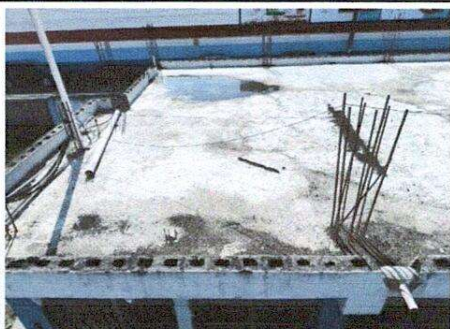
Mantenimiento de losa con impermeabilizante en área de salón de cómputo, pasillo y dirección.
