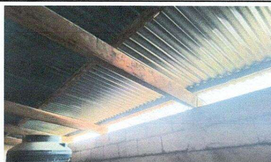
Sustitución de marcos con malla galvanizada de 0.25 m de alto con tubo de 1"x 1" en área de módulo de sanitarios 2.
