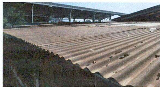
Sustitución de lámina acanalada calibre 26 en aulas de primero sección F y sección G.
