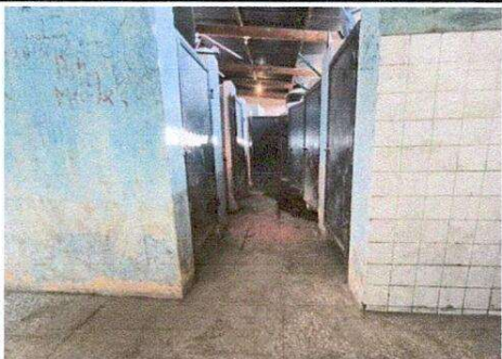
Mantenimiento de piso en módulo de sanitarios 2.
