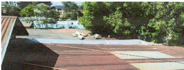
Sustitución de flashing de lámina galvanizada en aulas de primero sección F y sección G.
