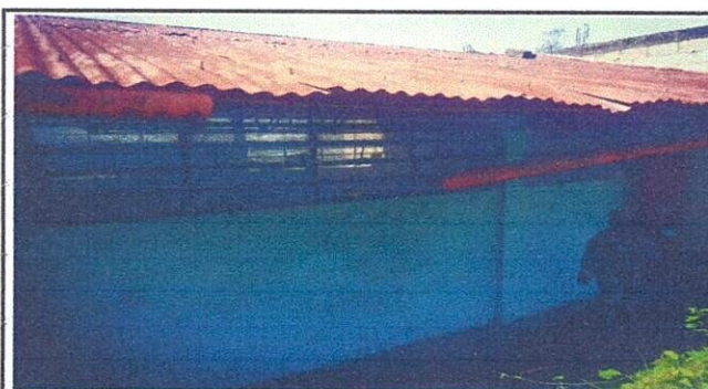
Sustitución de lámina acanalada por lamina troquelada calibre 26 incluido capotes y canales de metal para modulo 1
