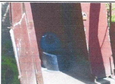
Sustitución de plancha de concreto por torta de cemento para baños
