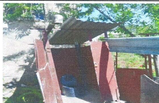
Sustitución de lámina acanalada y estructura de madera por lámina troquelada calibre 26 con estructura de metal
