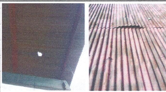
Sustitución de lámina acanalada por lámina troquelada calibre 26 incluido capotes de metal para módulo 3
