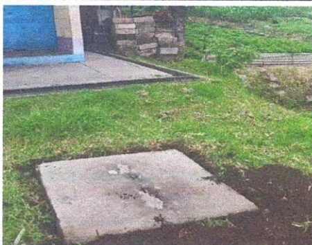
Mantenimiento correctivo de fosa séptica
