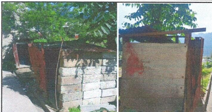
Mantenimiento correctivo y sustitución de pared de tablayeso y lámina por pared prefabricada de concreto para sanitarios
