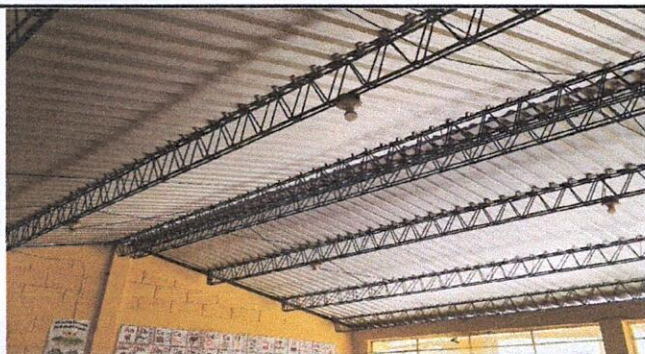
Sustitución de bombillo LED globo 30W 2400 lumenes, sustitución de plafoneras, modulo 1
