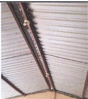
Sustitución de bombillo LED globo 30W 2400 lumenes, sustitución de plafoneras, modulo 4
