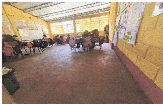
Mantenimiento, sustitución de piso de concreto a piso cerámico, modulos 1, 2, 3 y 4.
