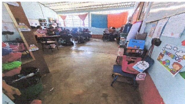
Mantenimiento, sustitución de piso de concreto a piso cerámico, modulos 1, 2, 3 y 4.
