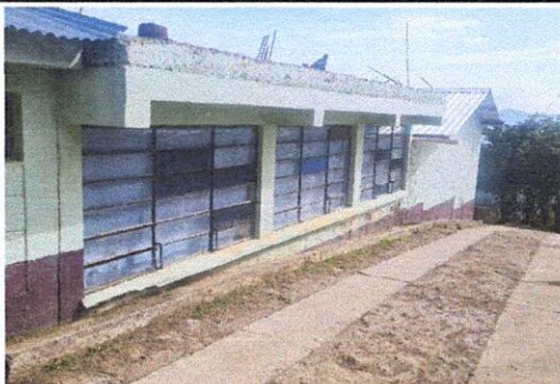
Suministro e instalación de balcones, modulo 3
