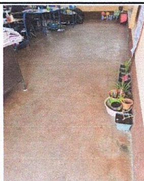
Mantenimiento, sustitución de piso de concreto a piso cerámico, modulos 1, 2, 3 y 4.
