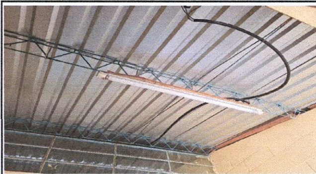
Sustitución de bombillo LED globo 30 W 2400 lumenes, sustitución de plafoneras, Suministro e instalación de cubierta con cielo falso de pvc y estructura de madera, modulo 1
