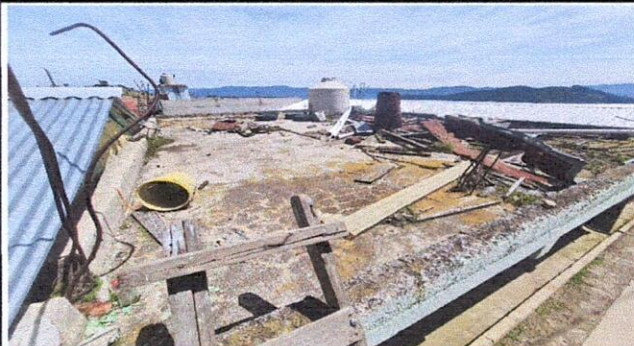
mantenimiento, impermeabilización de losa con bloqueador de agua 10 años, modulo 3
