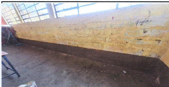
Repello y cernido en paredes existentes, modulos 1 y 2
