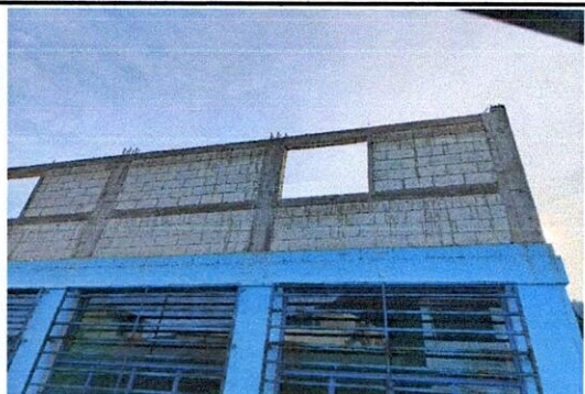
Mantenimiento correctivo con suministro de canal de metal, módulo 5
