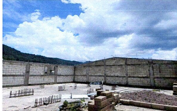
Mantenimiento correctivo con suministro de estructura de soporte de metal, módulo 5
