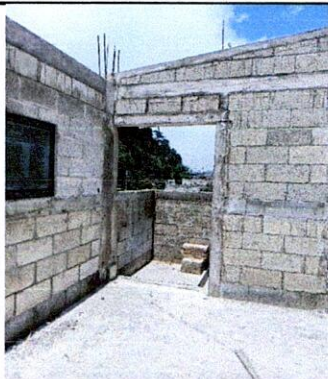
Mantenimiento correctivo con suministro de puerta metálica, módulo 5
