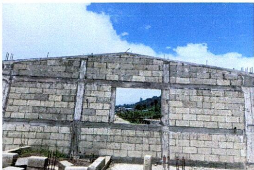
Mantenimiento correctivo con suministro estructura de metal de ventana, módulo 5
