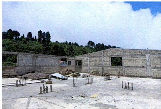
Mantenimiento correctivo con suministro e instalación de lámina troquelada calibre 26, módulo 5
