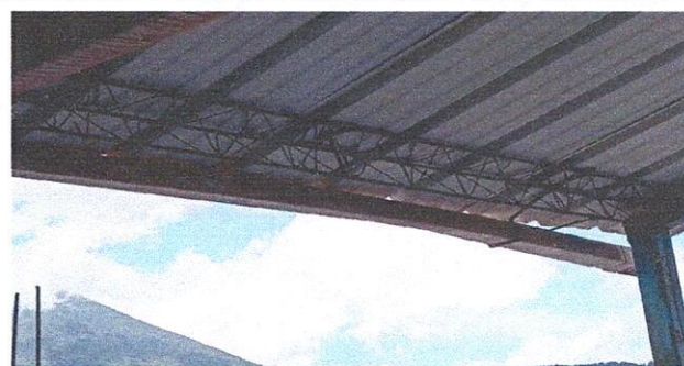
FOTO 2: SUSTITUCIÓN DE CANAL GALVANIZADO
