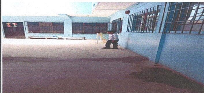
FOTO 9: SUMINISTRO Y APLICACIÓN DE ZÓCALO EN PARED PRIMER NIVEL
