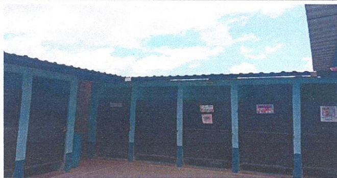
FOTO 3: MANTENIMIENTO DE CANAL GALVANIZADO, EN BAÑOS, SUMINISTRO Y APLICACIÓN DE PINTURA EXTERIOR EN BAÑOS
