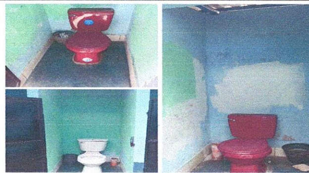
FOTO 4: REPELLO Y SUSTITUCIÓN DE AZULEJO Y PISO EN BAÑOS
