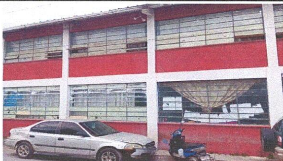
FOTO 1: SUSTITUCIÓN DE VIDRIOS CLAROS A NEVADOS Y COLOCACIÓN DE BALCONES, SUMINISTRO Y APLICACIÓN DE PINTURA EN FACHADA Y LETRAS DEL ESTABLECIMIENTO
