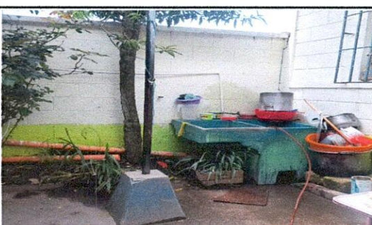
Sustitución de pilas y mantenimiento de desagües área de cocina
