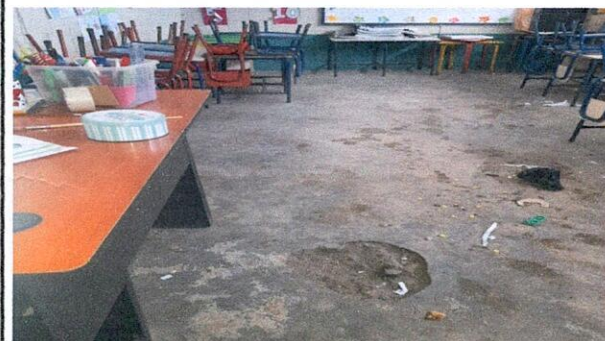
Sustitución de piso de cemento, nivelación por piso cerámico aula de preprimaria
