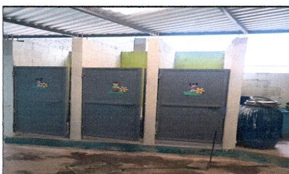
Mantenimiento correctivo de servicios sanitarios de pre primaria
