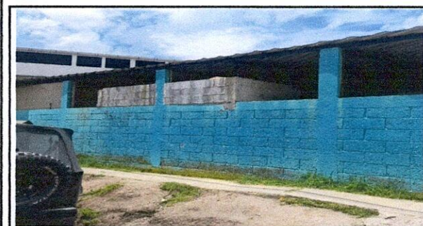
Sustitución de malla en muro perimetral por balcones parte externa del establecimiento
