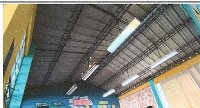
Mantenimiento Correctivo con suministro e instalación de cielo falso de duroport.
