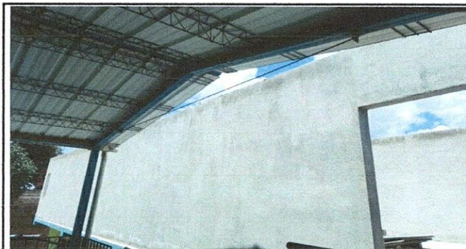
Mantenimiento Correctivo con suministro e instalación de canal pluvial.
