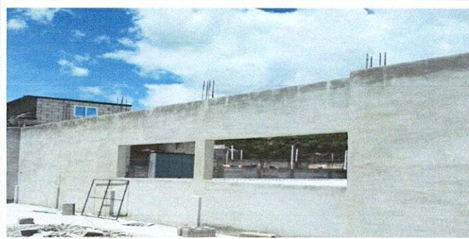
Mantenimiento Correctivo con suministro e instalación de ventanas de upvc de (2.50x1.04) y (2.20x1.04)
