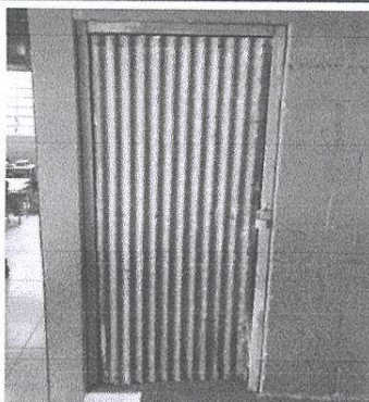
Sustitución de puerta metálica en área de dirección.
