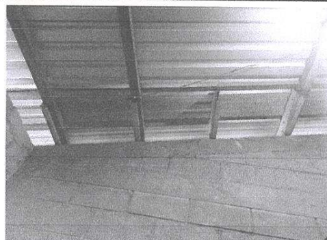
Reparación de muro entre techo y muro existente en área de dirección.
