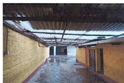
Sustitución de estructura de madera por estructura de metal en área de patio módulo 1
