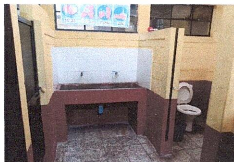
Sustitución de lavamanos de concreto por lavamanos de concreto en baños de hombres
