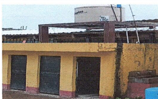
Mantenimiento de red de tubería para depósito de agua para baño de hombres y mujeres
