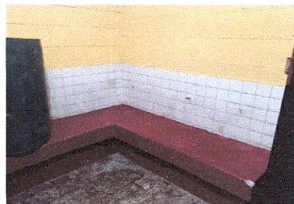
Sustitución de pared rústico por azulejo en baños hombres y mujeres
