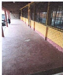
Sustitución de piso concreto por piso cerámico en corredor módulo 1, y 2
