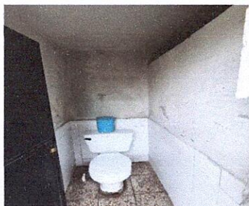
Sustitución de taza sanitaria por taza sanitaria en baños hombres
