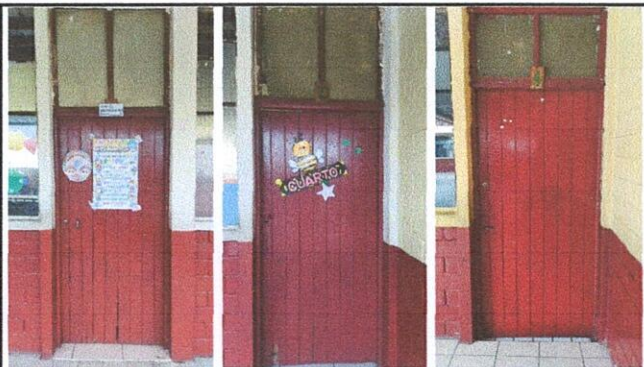
Sustitución de puerta de madera enchapada
