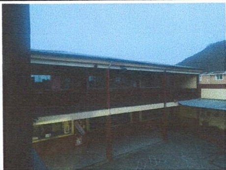
Sustitución de canal de metal
