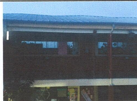
Sustitución de lámina por lámina troquelada calibre 26 segundo nivel módulo A (alero)
