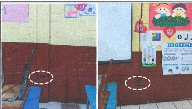
Sustitución de tomacorrientes dobles
