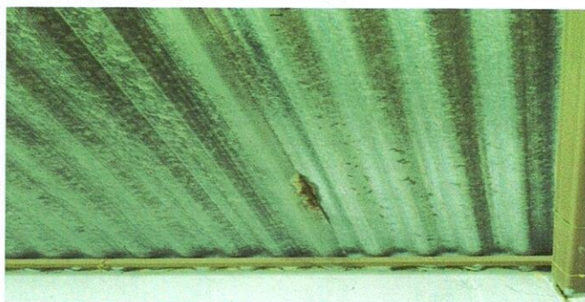
Instalación de canal pluvial de 50 cm , en alto caudal en módulo 2 , Instalación de tubo PVC para bajada pluvial de canal del módulo 2
