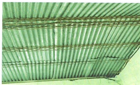
Sustitución de lámina acanalada calibre 26 en 3 aulas del módulo 1
