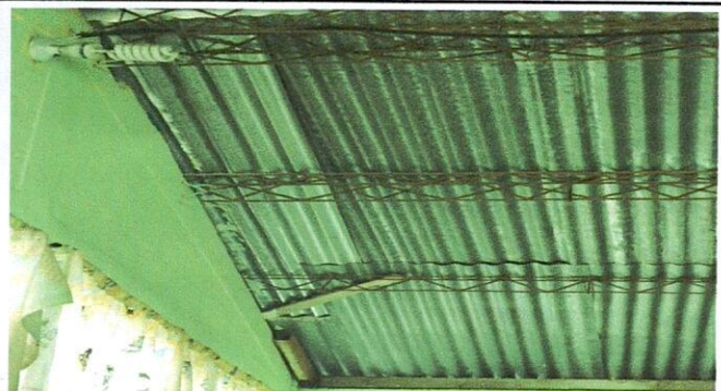
Sustitución de lámina acanalada calibre 26 en 3 aulas del módulo 1
