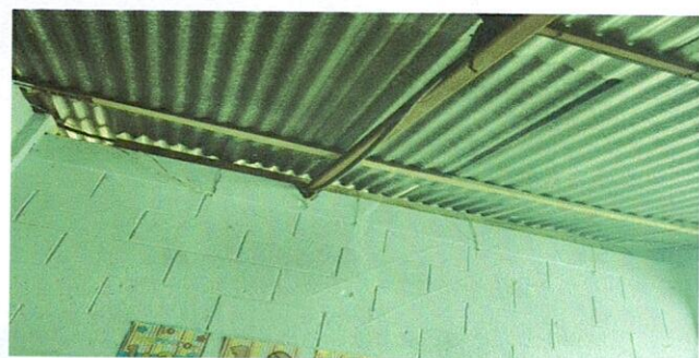
Instalación de costaneras en un aula de 3" X 2" galvanizada
