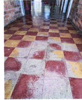
Sustitución de Piso de Granito con Porcelanato en área de salón principal.
