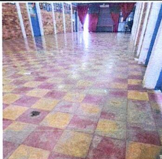
Sustitución de Piso de Granito con Porcelanato en área de salón principal.
