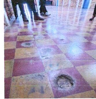
Sustitución de Piso de Granito con Porcelanato en área de salón principal.
