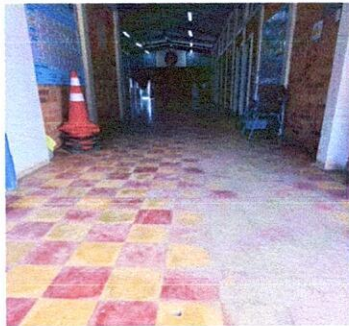
Sustitución de Piso de Granito con Porcelanato en área de salón principal.
