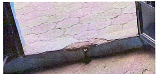
Sustitución de Grada de Ingreso por Rampa de Ingreso
