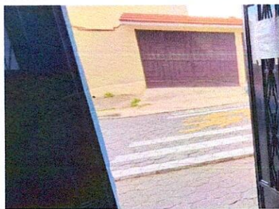
Sustitución de Portón Metálico, tres hojas, puerta peatonal, pasadores, chapa, ventana y pintura color negra a dos manos.
