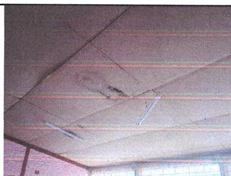
Sustitución cielo falso un aula.
