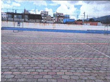
Suministro y aplicación de pintura.
