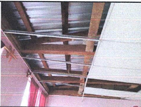
Sustitución de cielo falso un aula grande.
