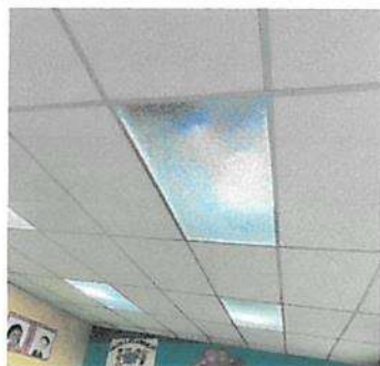
Sustitución de cielo falso tipo reticulado, en 4 aulas
