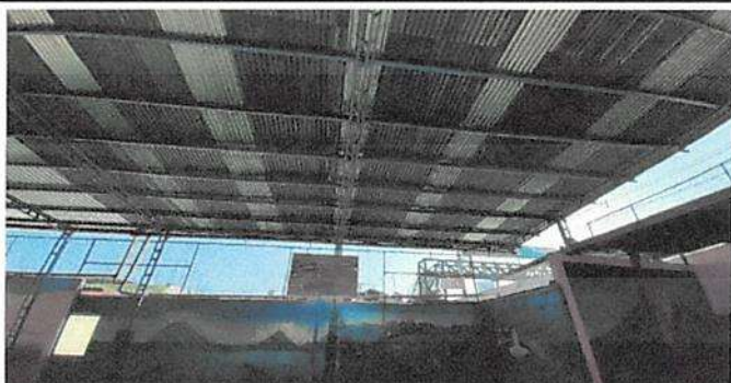
Sustitución de lámina por lámina troquelada calibre 26
