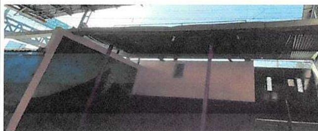
Sustitución de canal por canal PVC para alto caudal
