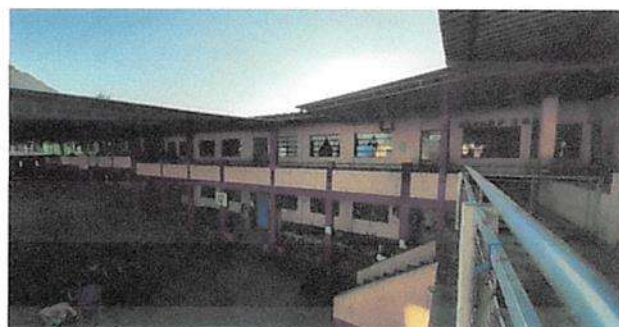
Suministro y aplicación de pintura Látex para exterior en aulas y patio
