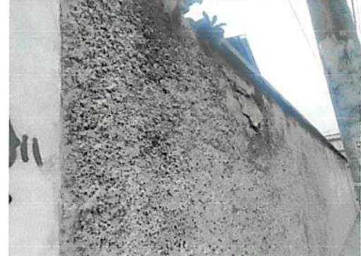
Terminación Mantenimiento muro perimetral exterior
