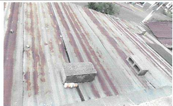
Sustitución lámina de aula
