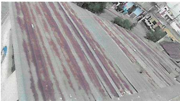
Sustitución lámina de aula
