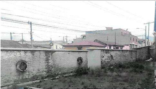
Mantenimiento muro perimetral interior
