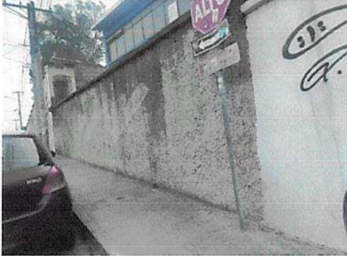
Terminación Mantenimiento muro perimetral exterior
