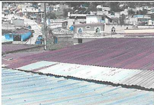
Sustitución de lámina, por lámina troquelada Calibre 26 en 2 aulas, Modulo 1 y sobre baños y pila Modulo 4
