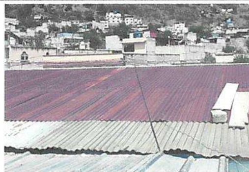
Sustitución de lámina, por lámina troquelada Calibre 26 en 2 aulas, Modulo 1 y sobre baños y pila Modulo 4
