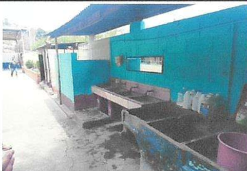
Sustitución de lámina, por lámina troquelada Calibre 26 en 2 aulas, Modulo 1 y sobre baños y pila Modulo 4
