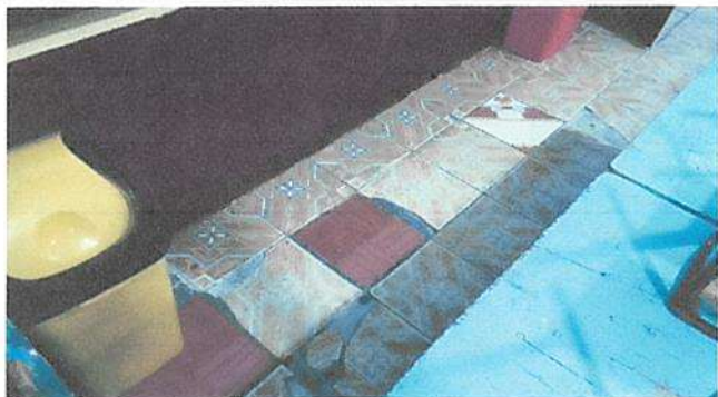
Sustitución de piso cerámico por piso de porcelanato en 1 aula y pasillo Modulo 1
