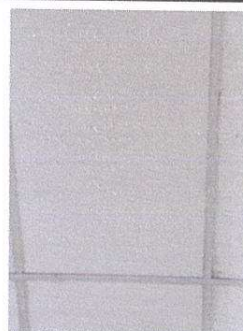
SUSTITUCIÓN CIELO FALSO AULAS MODULO 2
