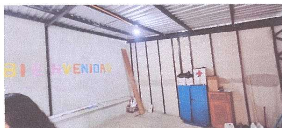
MANTENIMIENTO CORRECTIVO AULA MODULO 1
