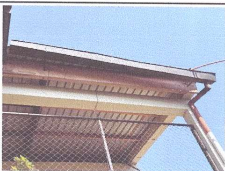
SUSTITUCIÓN CANAL 2 MODULO 2
