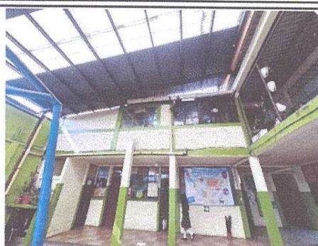
SUSTITUCIÓN CANAL 1 MODULO 3
