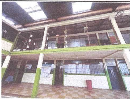
SUSTITUCIÓN Y MANTENIMIENTO DE MALLA MODULO 2
