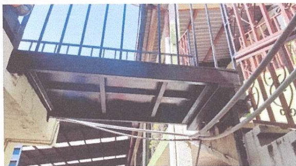
MANTENIMIENTO CORRECTIVO DE RAMPA MODULO 1
