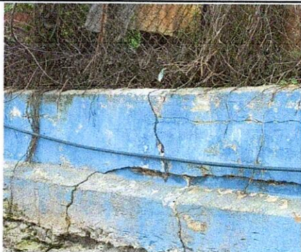
Sustitución de muro de contención: Presenta grietas y fisuras en diferentes direcciones.
