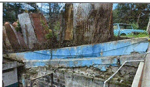
Sustitución de muro
