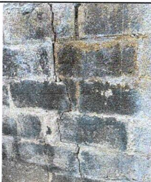
Sustitución de muro de contención: Presenta grietas y fisuras en diferentes direcciones.
