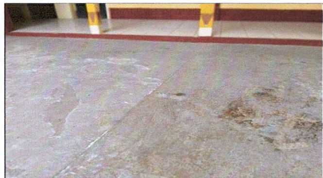
sustitucion de tuberia aguas negras
