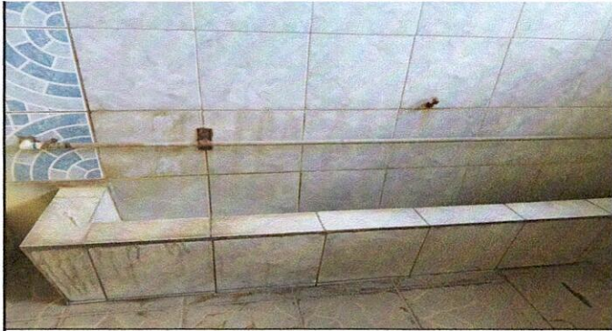
Sustitución de mingitorio a 3 mingitorios tipo orinales ecologicos y sustitución de azulejo del area de mingitorio
