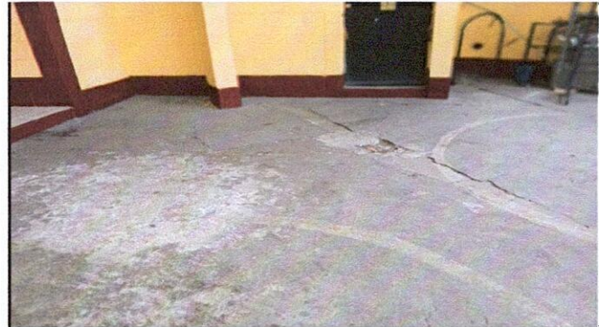
Sustitución de 131 M2 de concreto a piso de patio
