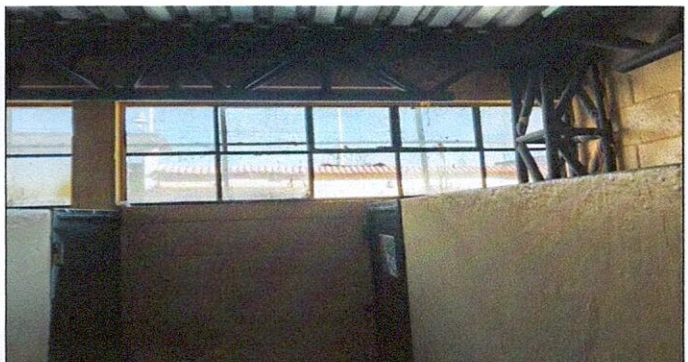
Sustitución de ventanas de metal a ventanas pvc
