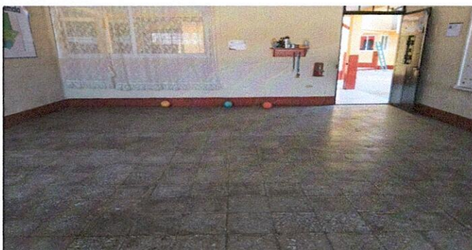
Sustitución de piso a piso ceramico en aula
