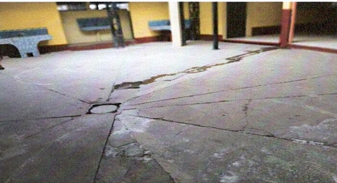
Sustitución de reposadera
