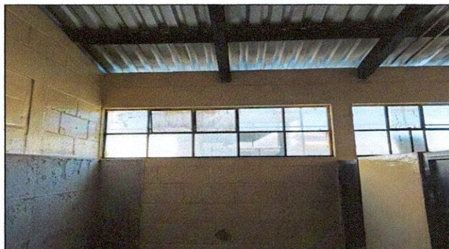
Sustitución de ventanas de metal a ventanas pvc
