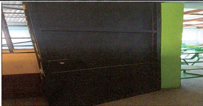
Mantenimiento a puertas de diferentes medidas
