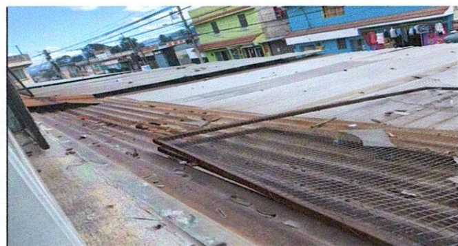
Sustitución de lamina en aula
