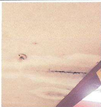
Reparación de muro y sustitución de plafoneras
