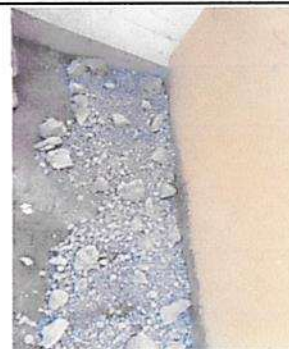
Sustitución de gradas de ingreso por rampas de ingreso
