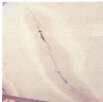
Reparación de columna
