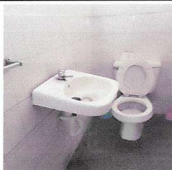
Sustitución inodoro elongado y sustitución lavamanos con grifera
