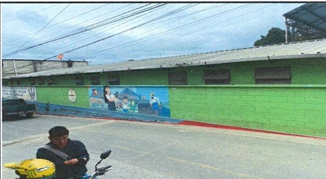
Mantenimiento correctivo con suministro e instalación ventanería PVC blanco con vidrio nevado claro de 1.00 x 1.00 m (14 unidades)
