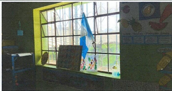
Mantenimiento correctivo con suministro e instalación ventanería PVC blanco con vidrio claro de 2.00 X 1.20 M (4 unidades)
