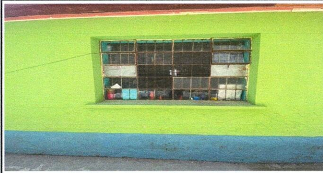
Mantenimiento correctivo con suministro e instalación balcón metálico con rejilla de hierro liso Ø 1/2" y marco de hierro angular de 1"x3/16" (2 unidades)
