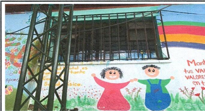
Mantenimiento preventivo de balcones existentes con lijado y aplicación de pintura anticorrosiva a dos manos (2 unidades)
