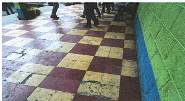
Mantenimiento correctivo de piso de concreto con suministro e instalación de piso granito en corredor
