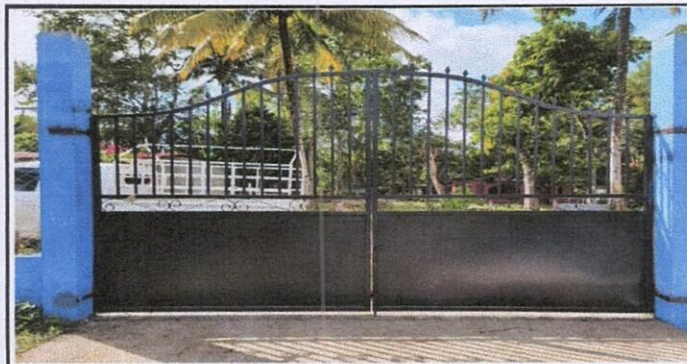
MANTENIMIENTO A PORTON METALICO
