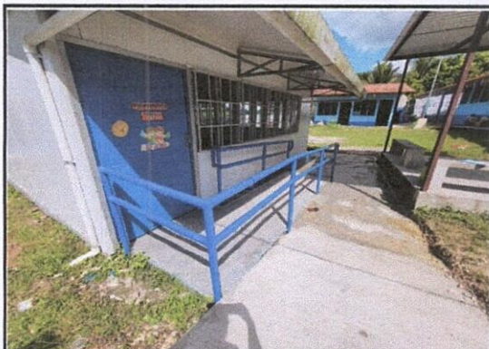
MANTENIMIENTO A BARANDAS
