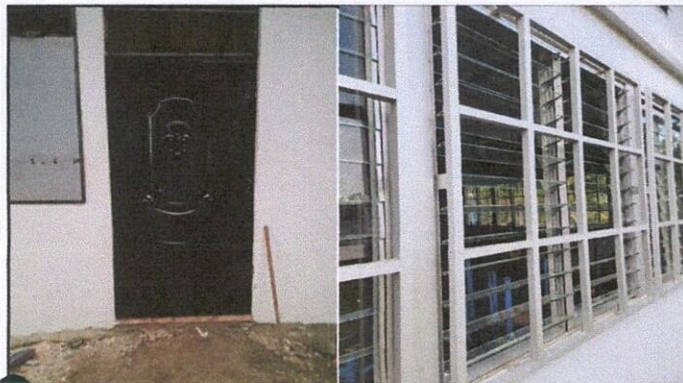
SUSTITUCION A PUERTA DE METAL, SUSTITUCION DE VENTANAS A VENTANAS DE PALETAS
