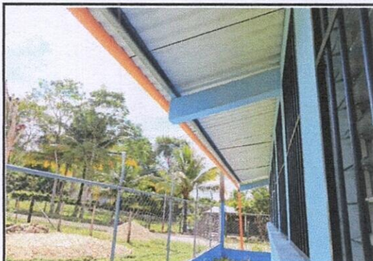
CANALES Y BAJADAS DE AGUA PLUVIAL
