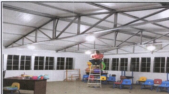
REPARACION SISTEMA ELECTRICO, SUSTITUCION DE FLAPONERAS, FOCOS, TOMACORRIENTES Y REPARACION DE CABLEADO
