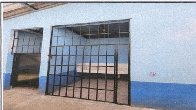
MANO DE OBRA ESPECIALIZADA, FABRICACION E INSTALACION DE PUERTA DE REJA, VENTANAS BALCON Y BALCONES DE HIERRO
