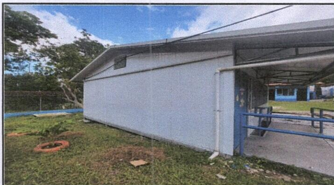
PINTURA EN MUROS EXTERIORES E INTERIORES
