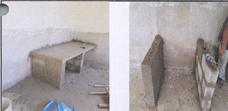
REPARACION DE COCINA. SUSTITUCION DE ESTUFA RURAL Y AZUJELO
