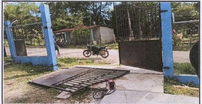
MANTENIMIENTO A PORTON METALICO
