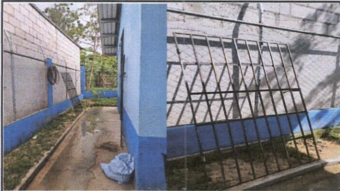
MANO DE OBRA ESPECIALIZADA, FABRICACION E INSTALACION DE PUERTA DE REJA, VENTANAS BALCON Y BALCONES DE HIERRO
