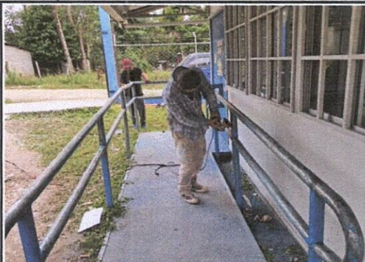
MANTENIMIENTO A BARANDAS
