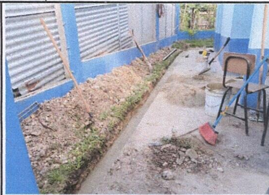
CUNETA DE CONCRETO
