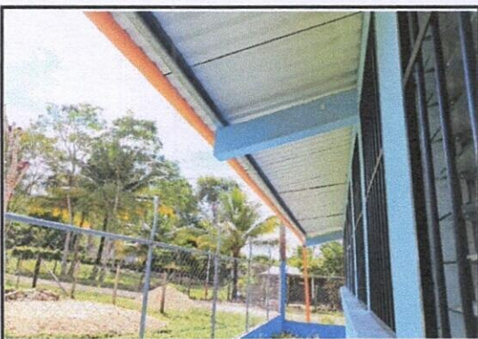
CANALES Y BAJADAS DE AGUA PLUVIAL
