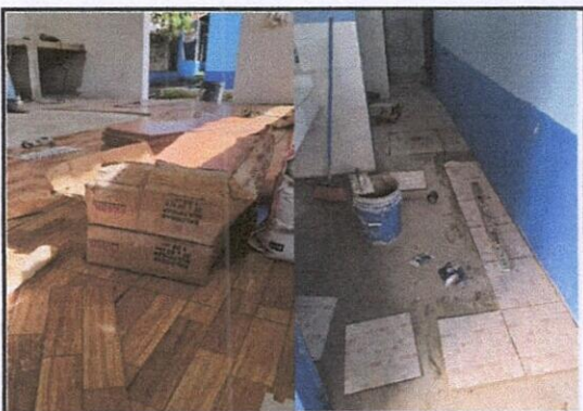
PISO MEJORAMIENTO DE PISO CERAMICO EN COCINA Y BAÑOS
