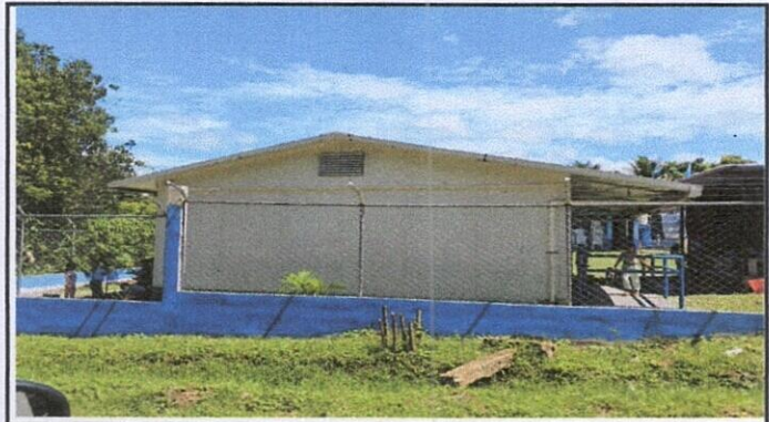
PINTURA EN MUROS EXTERIORES E INTERIORES
