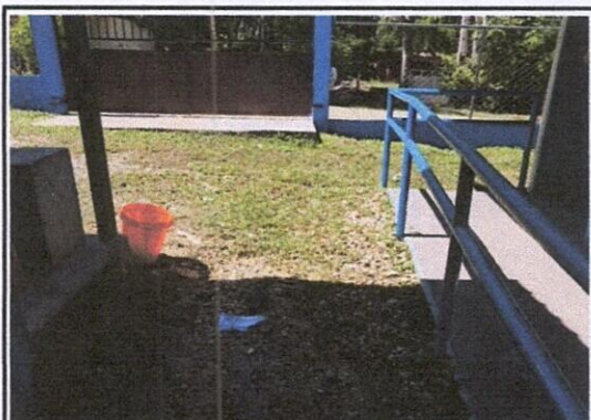
MANTENIMIENTO A BARANDAS
