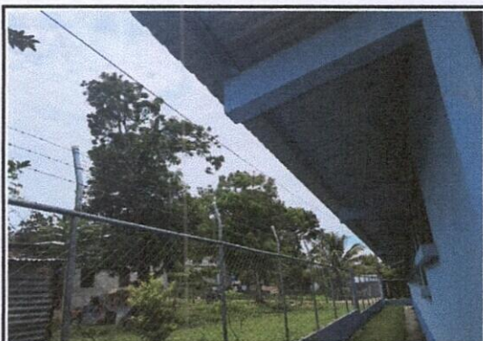
CANALES Y BAJADAS DE AGUA PLUVIAL
