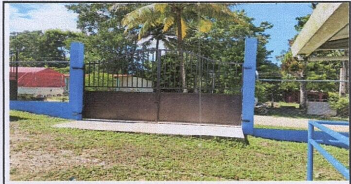
MANTENIMIENTO A PORTON METALICO
