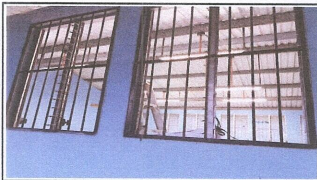
Foto 3: MANTENIMIENTO A VENTANAS Y BALCONES METALICOS (LIJADO, CEPILLADO Y APLICACIÓN DE PINTURA)
