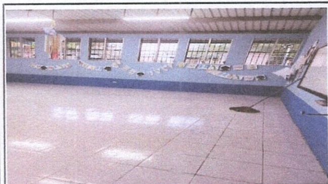
Foto: 9 SUSTITUCION DE PISO A CERAMICA
