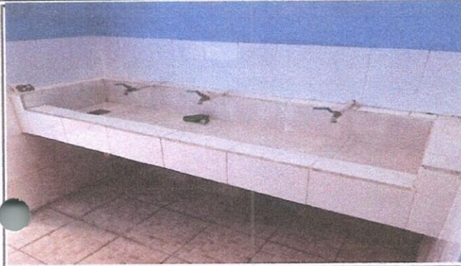
Foto 7 REPARACION DE LAVAMANOS
