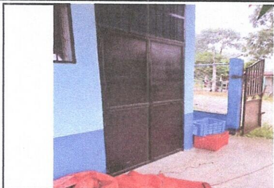
Foto 1: MANTENIMIENTO A PUERTAS METALICAS (LIJADO, CEPILLADO, CAMBIO DE CHAPA Y APLICACIÓN DE PINTURA)
