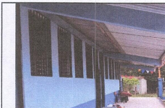
Foto 4: MANTENIMIENTO A BALCONES METALICOS
