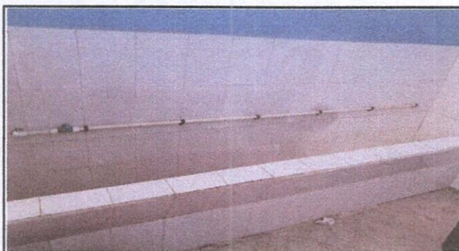
Foto: REPARACION DE MIGITORIO
