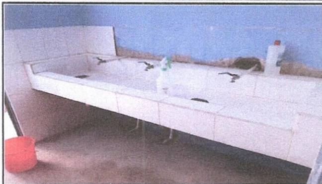
FOTO: REPARACION DE LAVAMANOS
