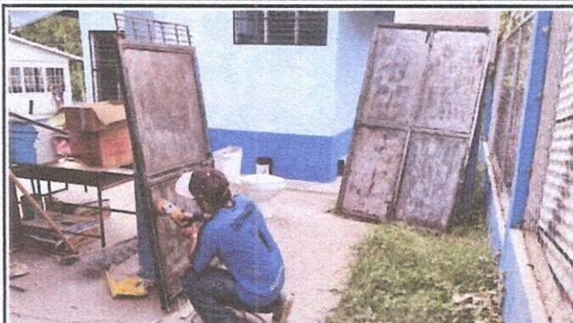
Foto 1: MANTENIMIENTO A PUERTAS METÁLICAS (LIJADO, CEPILLADO, CAMBIO DE CHAPA Y APLICACIÓN DE PINTURA)
