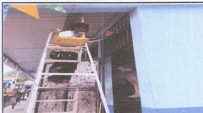
Foto 4: MANTENIMIENTO A BALCONES METÁLICOS
