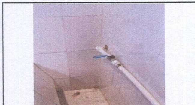
Foto: REPARACION DE MIGITORIO
