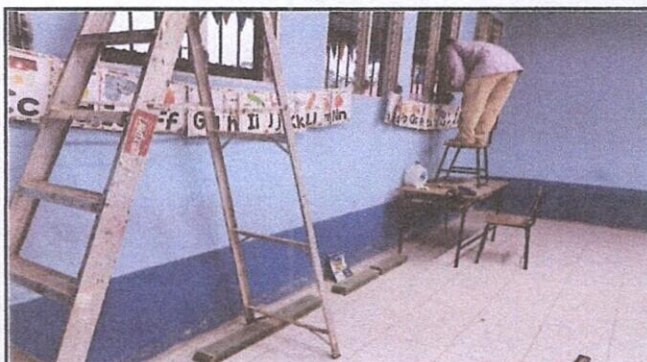
Foto 3: MANTENIMIENTO A VENTANAS Y BALCONES METÁLICOS (LIJADO, CEPILLADO Y APLICACIÓN DE PINTURA)
