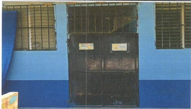
Foto 1: MANTENIMIENTO A PUERTAS METALICAS (LIJADO, CEPILLADO, CAMBIO DE CHAPA Y APLICACIÓN DE PINTURA)
