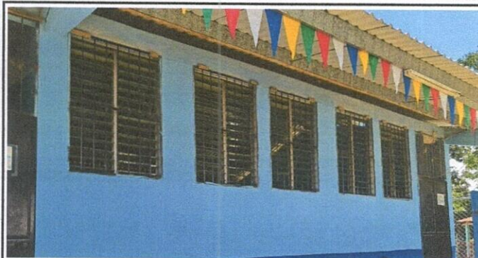
VENTANAS: MANTENIMIENTO A BALCONES DE METAL(LIJADO, CEPILLADO)
