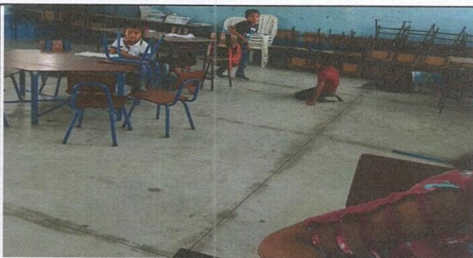
PISO. Mejoramiento de piso de concreto a piso ceramico.
