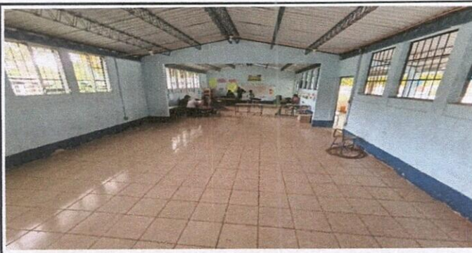
Foto 6: Aula 2 y 3 sustitución piso de cemento por piso cerámico, medidas del aula 2 5.88 por 9.97 y medidas del aula 3 7.27 por 7.22,
