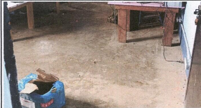
Foto 4: 4 Computación sustitución piso de cemento por piso cerámico, medidas 2.88 por 5.24
