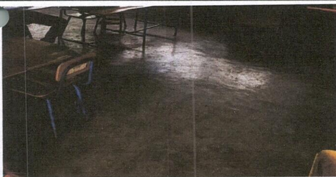
Foto 5: Aula 1 sustitución piso de cemento por piso cerámico, medidas 5.88 por 7.90
