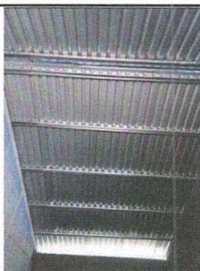
Foto 3: SUSTITUCIÓN ELEMENTOS DE FIJACIÓN
