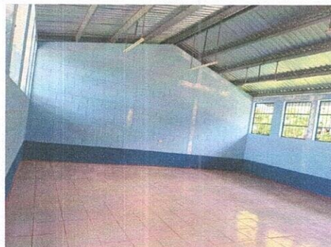
INSTALACION DE LAMINA.
