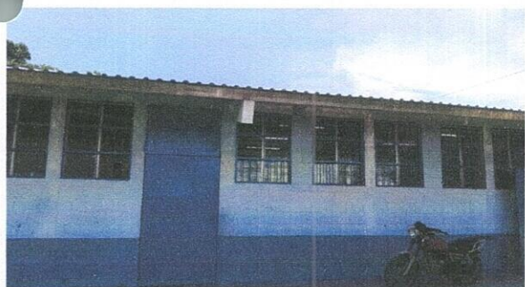
Foto 5: SUSTITUCION DE LAMINA EXISTENTE
