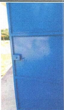
Foto 5: SUSTITUCIÓN DE CHAPA
