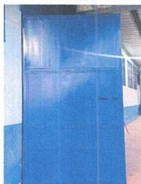
Foto 4 : MANTENIMIENTO A ESTRUCTURA, (LIJADO, CAMBIO DE TUBO, CEPILLADO, SUJECIONES, APLICACIÓN DE PINTURA)
