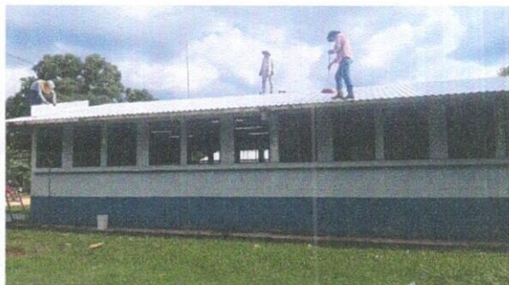
Foto 3: SUSTITUCIÓN ELEMENTOS DE FIJACIÓN
