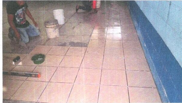
Foto 8: MEJORAMIENTO DE PISO
