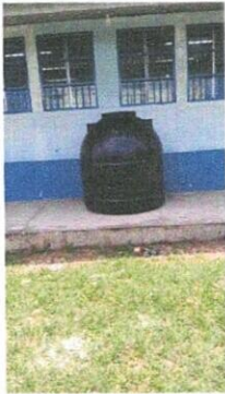
Foto 9: SUSTITUCIÓN DE DEPÓSITO DE AGUA, 1700 LTS
