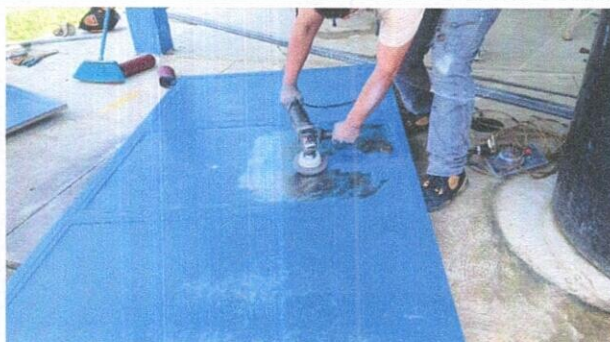
Foto 4 : MANTENIMIENTO A ESTRUCTURA, (LIJADO, CAMBIO DE TUBO, CEPILLADO, SUJECCIONES, APLICACIÓN DE PINTURA)
