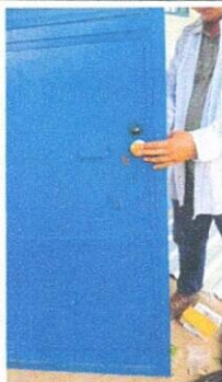
Foto 5: SUSTITUCIÓN DE CHAPA
