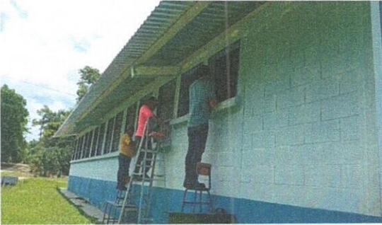
Foto 7: MANTENIMIENTO A BALCONES DE METAL
