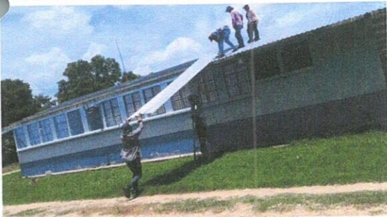
Foto 11: DESINSTALACIÓN DE LAMINA EXISTENTE
