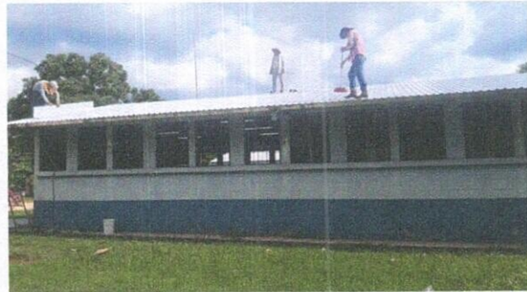
Foto 10: INSTALACIÓN DE LAMINA TROQUELADA ALUZING
