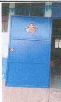
Foto: 5 SUSTITUCIÓN DE CHAPA
