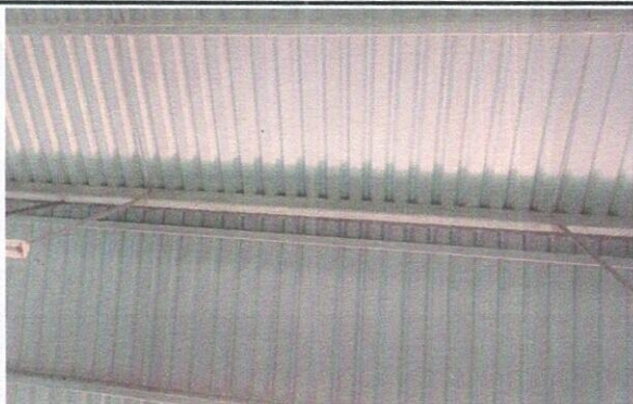
Foto: 3 SUSTITUCIÓN ELEMENTOS DE FIJACIÓN
