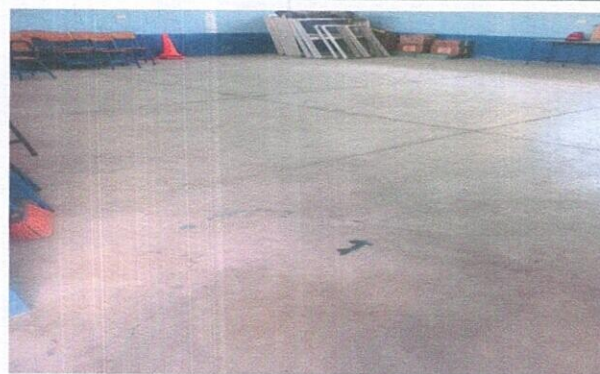
Foto 8: MEJORAMIENTO DE PISO
