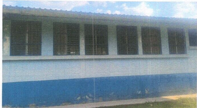
Foto 7: MANTENIMIENTO A BALCONES DE METAL
