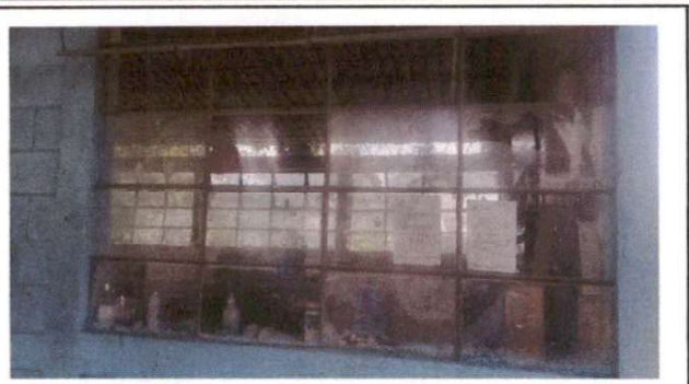
Foto 2: SUSTITUCIÓN DE BALCONES DE METAL
