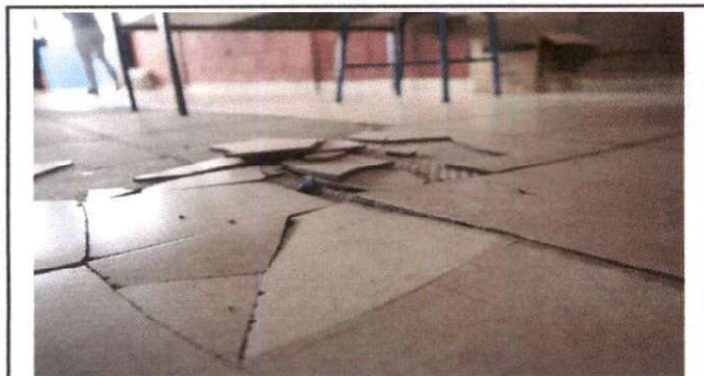
Foto 3: SUSTITUCIÓN DE PISO CERÁMICO
