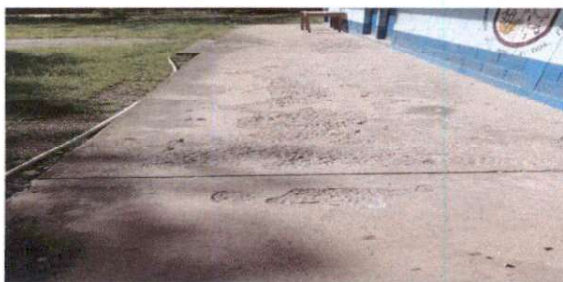
Foto 5: 6.5 Sustrucción de piso de torta de concreto
