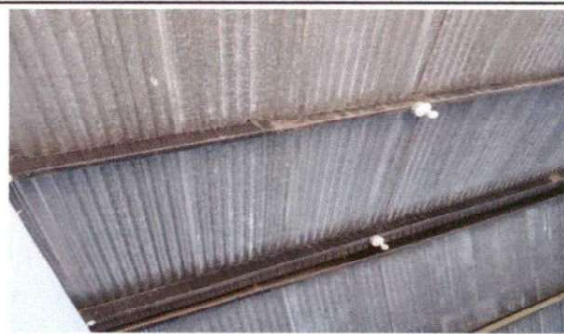
Foto 2: 2.1 Mantenimiento a estructura de soporte de metal
