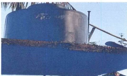
Foto 9: 18.3 Sustitución de deposito de agua 1700 lt
