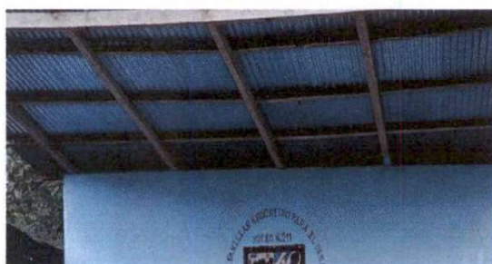
Foto 3: 2.2 Sustrucción de estructura de soporte de madera, por metal
