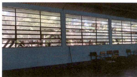
Foto 4: 5.2 Sustrucción de estructura de metal de ventana
