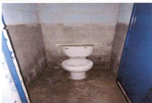
Foto7: 10.3 Sustitución de inodoros.
