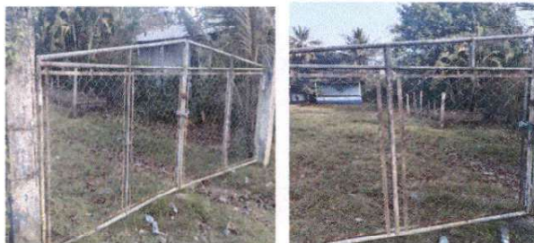
Foto 10: 19.5 Fabricación e instalación de portón de metal de ingreso
