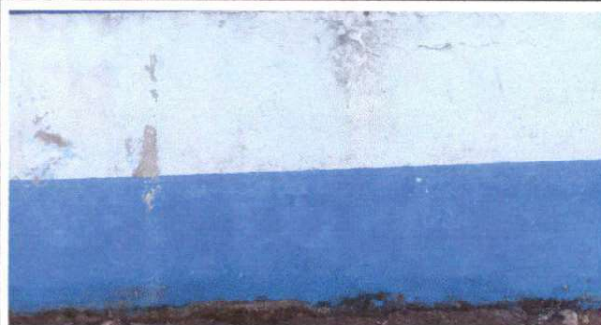
Foto 6: 9.1 Pintura en muros exteriores e interiores
