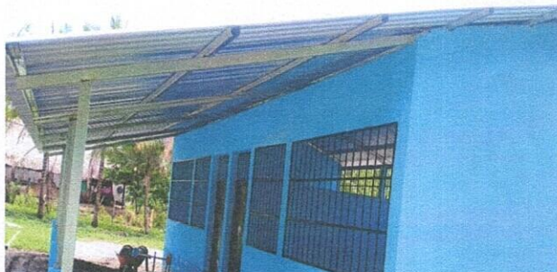
Foto 3: 1.3 Sustitución de elementos de fijación
