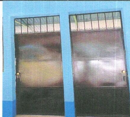
Foto8: 19.3 Fabricación e instalación de puertas de metal en módulos
