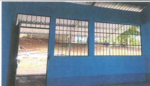
Foto7: 19.1 Fabricación e instalación de ventana-balcón de metal
