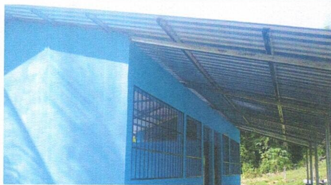
Foto 9: 19.8 Instalación de lámina troquelada aluzinc
