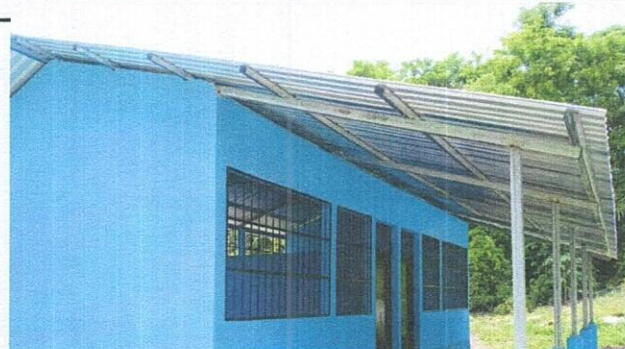
Foto 4: 2.2 Sustitución de estructura soporte de madera por metal
