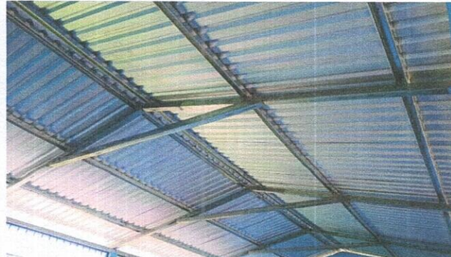
Foto 2: 1.2 Sustitución de capote de lámina por lamina troquelada
