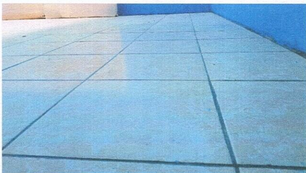
Foto 5: Mejoramiento de piso
