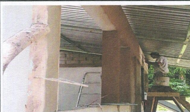
Foto 10: 21.1 repello en muros
