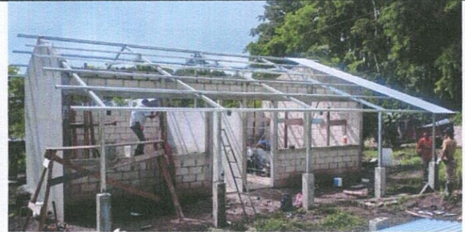
Foto 4: 2.2 Sustitución de estructura soporte de madera por metal
