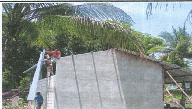
Foto 9: 19.8 Instalación de lámina troquelada aluzinc
