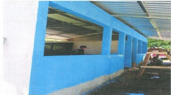
Foto 6: Pintura en Interiores y Exteriores
