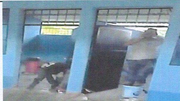
Foto8: 19.3 Fabricación e instalación de puertas de metal en módulos
