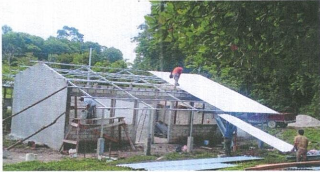
Foto 1: 1 Sustitución de lámina, por lámina troquelada aluzinc calibre 26
