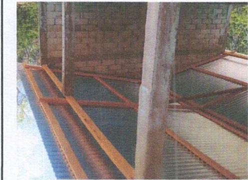
Foto. 19.8 Instalación de lamina troquelada aluzinc
