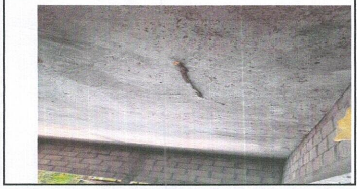
Foto: 6.8 Mejoramiento de piso
