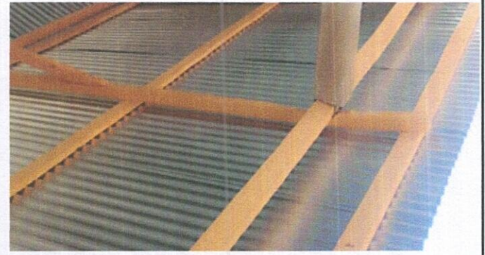
Foto: 1.3. Sustitución de elementos de fijación
