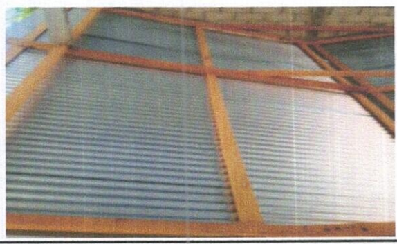
Foto 1.1. Sustitución de lámina, por lámina troquelada aluzinc calibre 26
