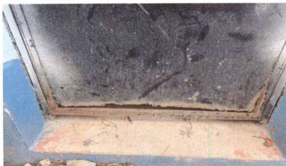
Foto 3: Sustitución de puertas
