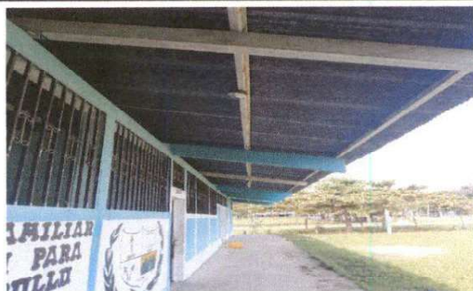
Foto 5: Pintura en muros exteriores e interiores
