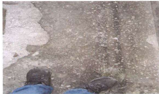
Foto 4: Sustitución de piso de torta de concreto
