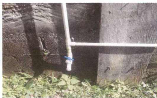
Foto 2: Sustitución de llave de chorro
