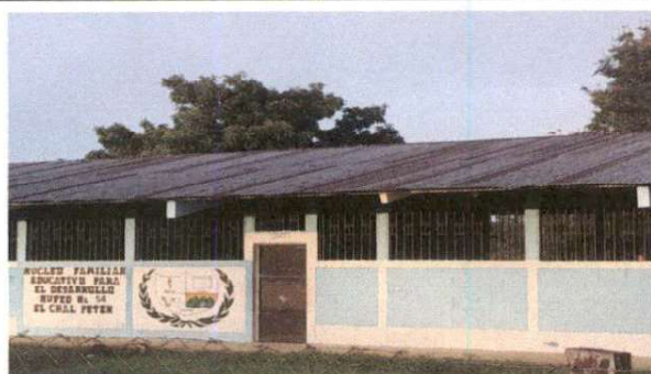
Foto 1: Desinstalación de lámina existente
