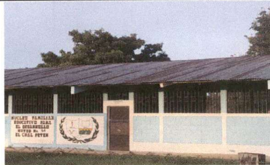
Foto 2: Sustitución de Capote de Lámina para lamina troquelada
