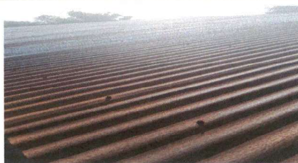
Foto 6: Instalación de lámina troquelada aluzinc
