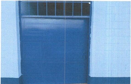
FOTO 1. MANTENIMIENTO A ESTRUCTURA, LIJADO, SEPILLADO, CAMBIO DE TUBO, SUJECIONES Y APLICACIÓN DE PINTURA
