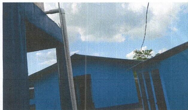
FOTO 8. SUSTITUCION DE TUBERIA LINEA PRINCIPAL
