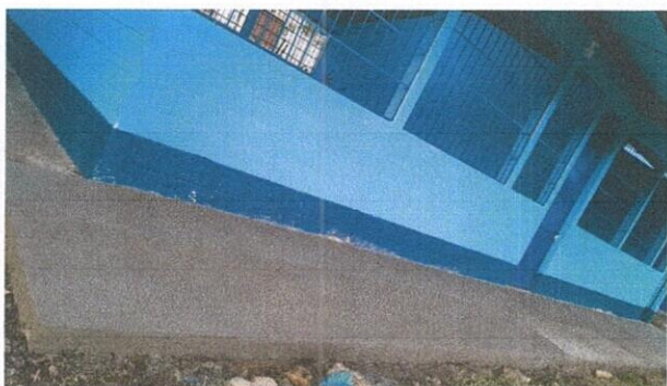
FOTO 3. SUSTITUCION DE PISO DE TORTA DE CONCRETO
