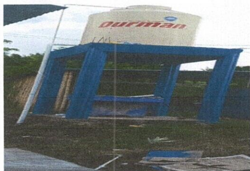
FOTO 9. SUSTITUCION DE DEPÓSITO DE AGUA DE 1,700 LITROS
