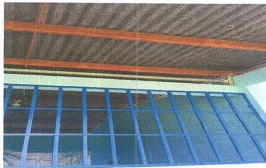
FOTO 2. MANTENIMIENTO A BALCONES DE METAL
