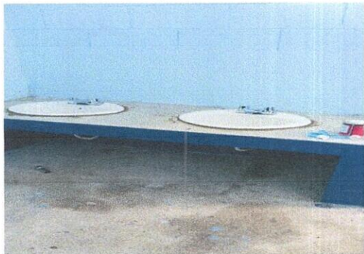
FOTO 7. SUSTITUCION DE LAVAMANOS
