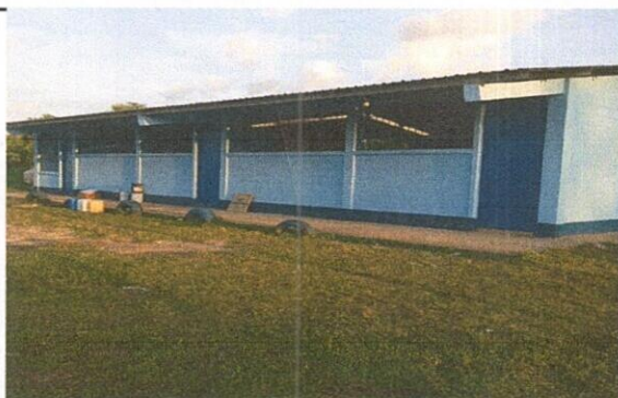
FOTO 5. PINTURA EN MUROS EXTERIORES E INTERIORES
