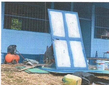
FOTO 1. MANTENIMIENTO A ESTRUCTURA, LIJADO, SEPIADO, CAMBIO DE TUBO, SUJECIONES Y APLICACIÓN DE PINTURA
