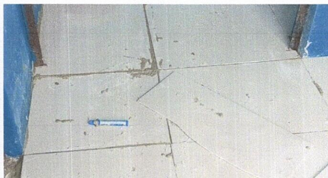
FOTO 4. SUSTITUCION DE PISO DE CEMENTO LIQUIDO
