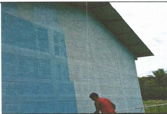
FOTO 5. PINTURA EN MUROS EXTERIORES E INTERIORES
