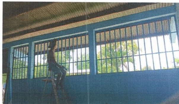
FOTO 2. MANTENIMIENTO A BALCONES DE METAL
