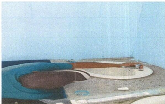
FOTO 7. SUSTITUCION DE LAVAMANOS
