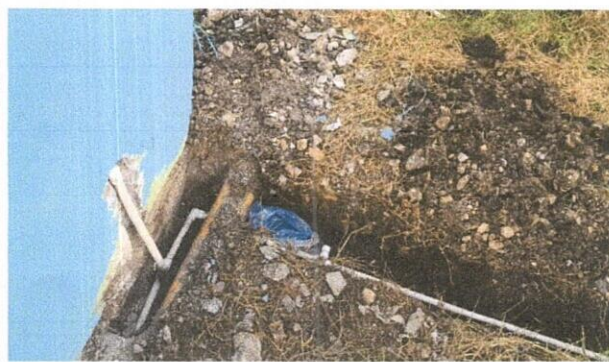
FOTO 8. SUSTITUCION DE TUBERIA LINEA PRINCIPAL
