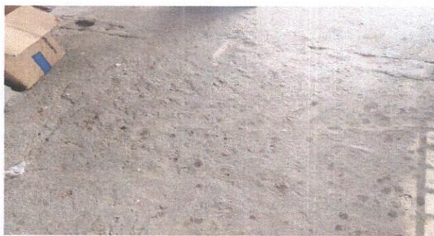
FOTO 3. SUSTITUCION DE PISO DE TORTA DE CONCRETO
