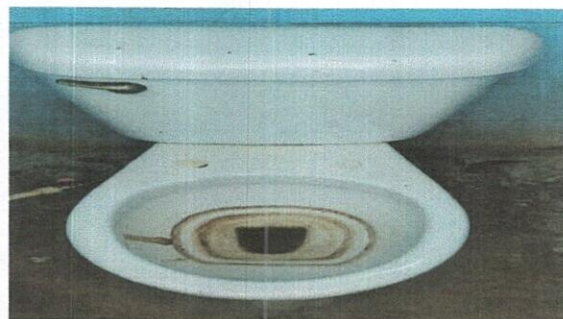
FOTO 6. SUSTITUCION DE INODOROS
