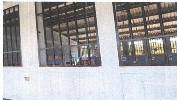
FOTO 2. MANTENIMIENTO A BALCONES DE METAL
