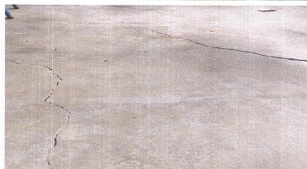
FOTO 4. MEJORAMIENTO DE PISO
