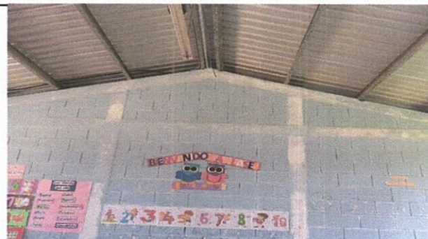
FOTO 5. PINTURA EN MUROS EXTERIORES E INTERIORES
