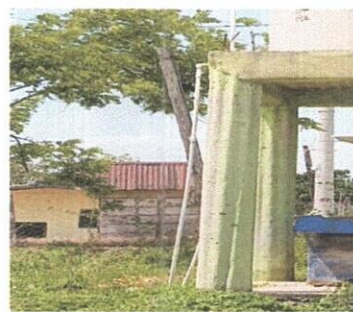
FOTO 8. SUSTITUCION DE TUBERIA LINEA PRINCIPAL
