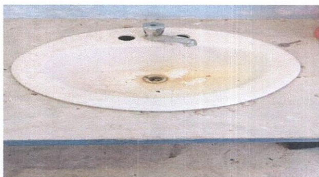
FOTO 7. SUSTITUCION DE LAVAMANOS
