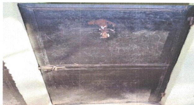
FOTO 1. MANTENIMIENTO A ESTRUCTURA, LIJADO, SEPILLADO, CAMBIO DE TUBO, SUJECIONES Y APLICACIÓN DE PINTURA
