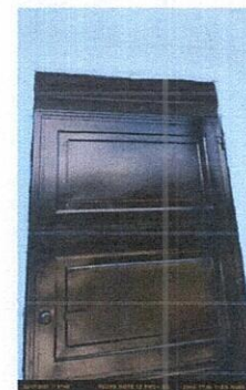
Foto 10: Sustitución de Puerta de Metal
