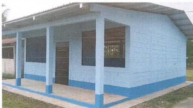
Foto 7: Reparación de Banqueta
