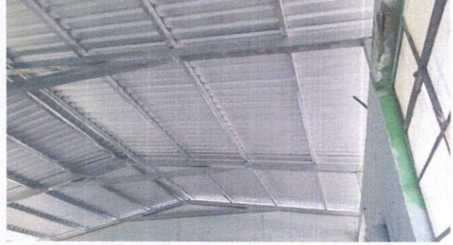
Foto 2: Sustitución de Estructura Portante
