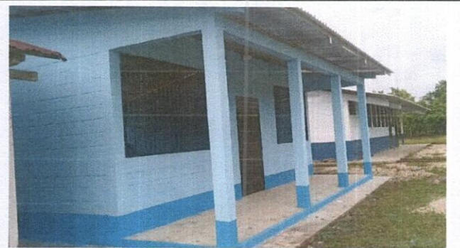
Foto 6: Pintura en Muro Interiores y Exteriores
