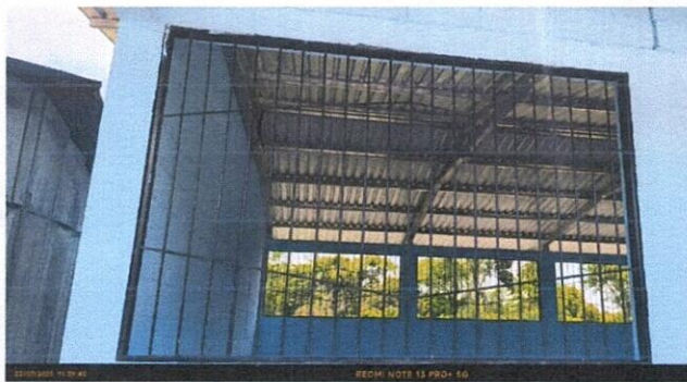
Foto 3: Mantenimiento a Balcones
