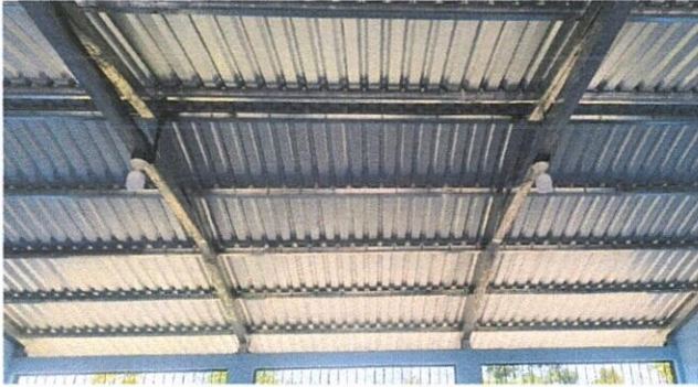
Foto 1: Sustitución de Lamina por Lamina Troquelada
