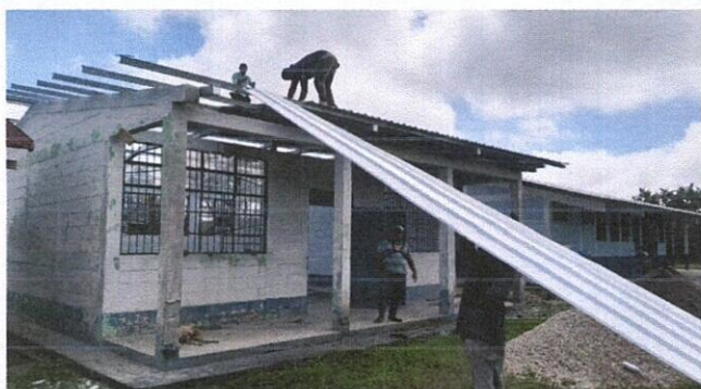
Foto 1: Sustitución de Lamina por Lamina Troquelada
