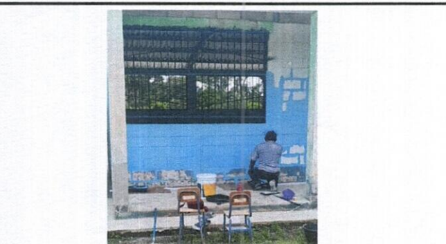
Foto 6: Pintura en Muro Interiores y Exteriores
