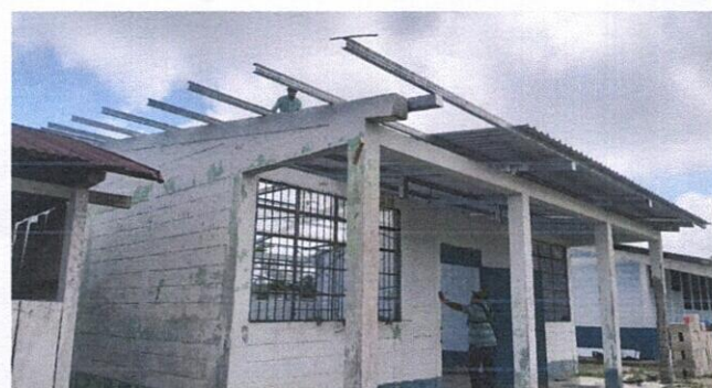
Foto 3: Mantenimiento a Balcones
