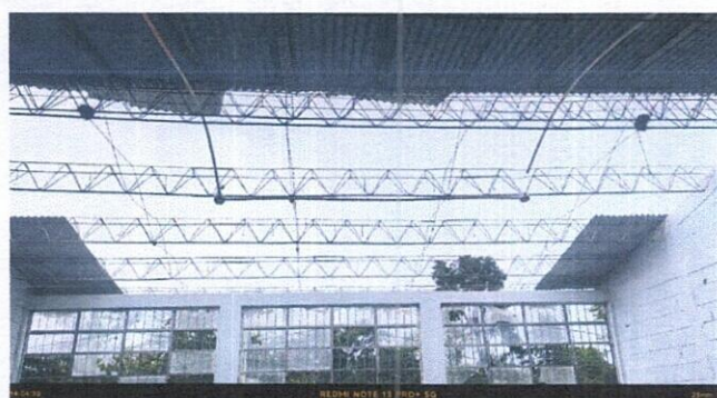
Foto 2: Sustitución de Estructura Portante
