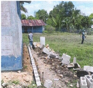
Foto 7: Reparación de Banqueta
