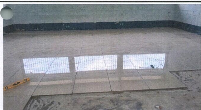
Foto 5: Sustitución de Piso Liquido
