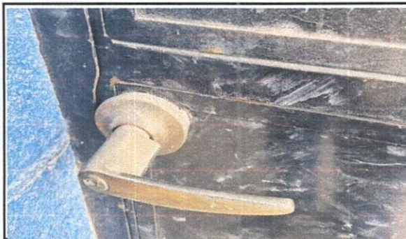
Foto 2: SUSTITUCION DE CHAPA
