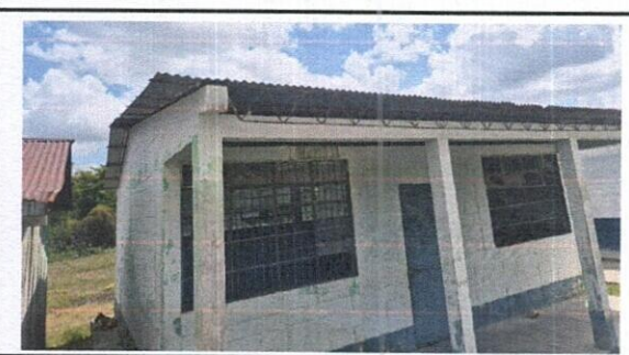
Foto 6: PINTURA EN MUROS INTERIORES Y EXTERIORES
