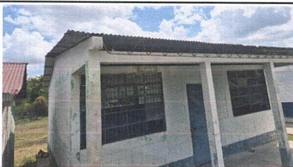
Foto 3: MANTENIMIENTO A BALCONES
