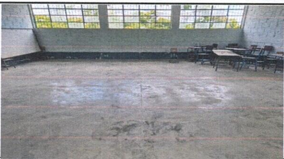
Foto 5: SUSTITUCION DE PISO LIQUIDO
