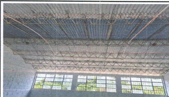
Foto 2: SUSTITUCION DE ESTRUCTURA PORTANTE
