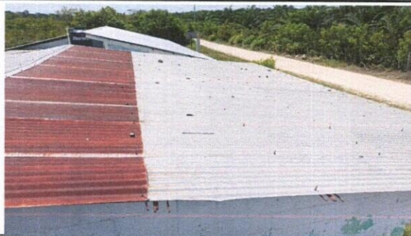
Foto 1: SUSTITUCION DE LAMINA POR LAMINA TROQUELADA
