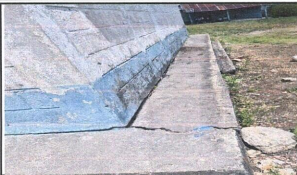
Foto 1: REPARACION DE BANQUETA
