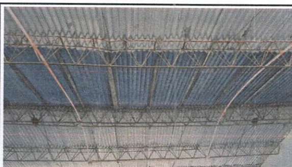
Foto 4: SUSTITUCION DE CABLEADO ELECTRICO
