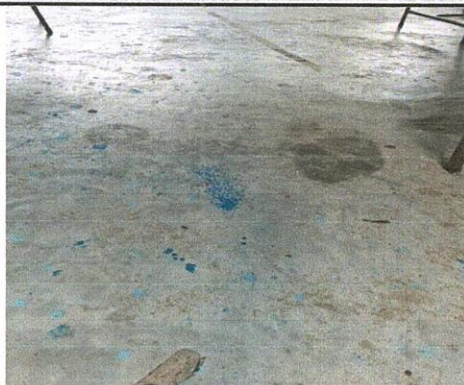
Foto 1: Mejoramiento de piso
