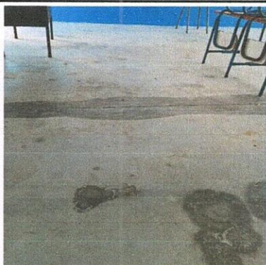
Foto 3: Mejoramiento de piso
