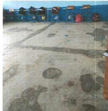
Foto 4: Mejoramiento de piso
