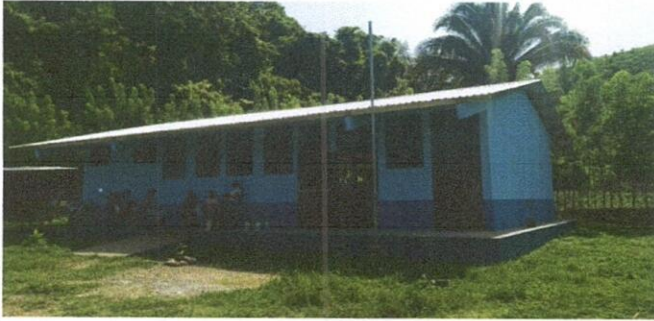
Foto 1: Sustitución de lámina, sustitución de capote y sustitución de elementos de fijación.
