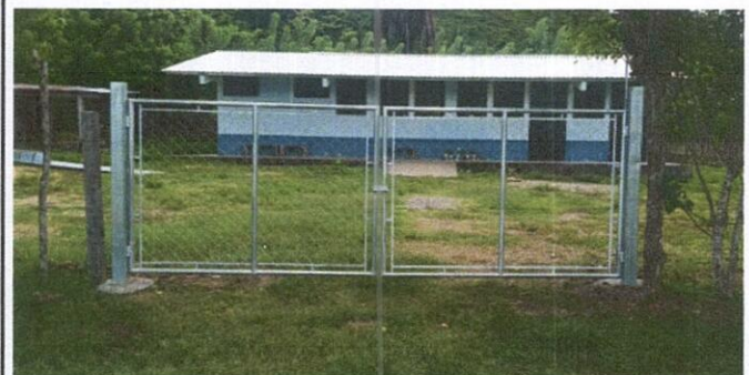
Foto 6: Suministro de portón de metal.
