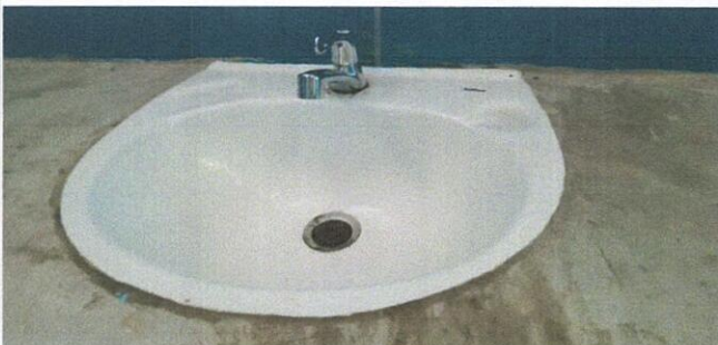
Foto 5: Sustitución de mezcladora lavamanos (contra llave, tubo de abasto)
